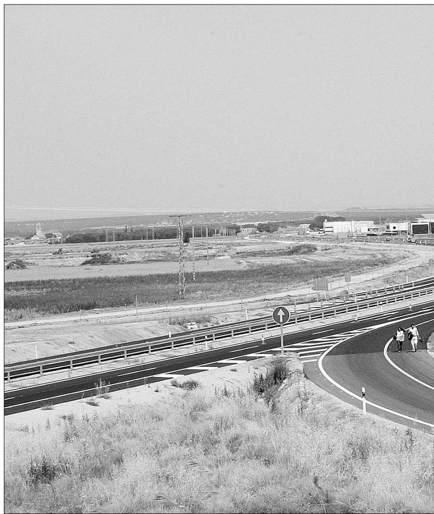
Acceso a la autovía A-601 desde el centro de conservación y mantenimiento de Portillo, en la provincia de Valladolid.
