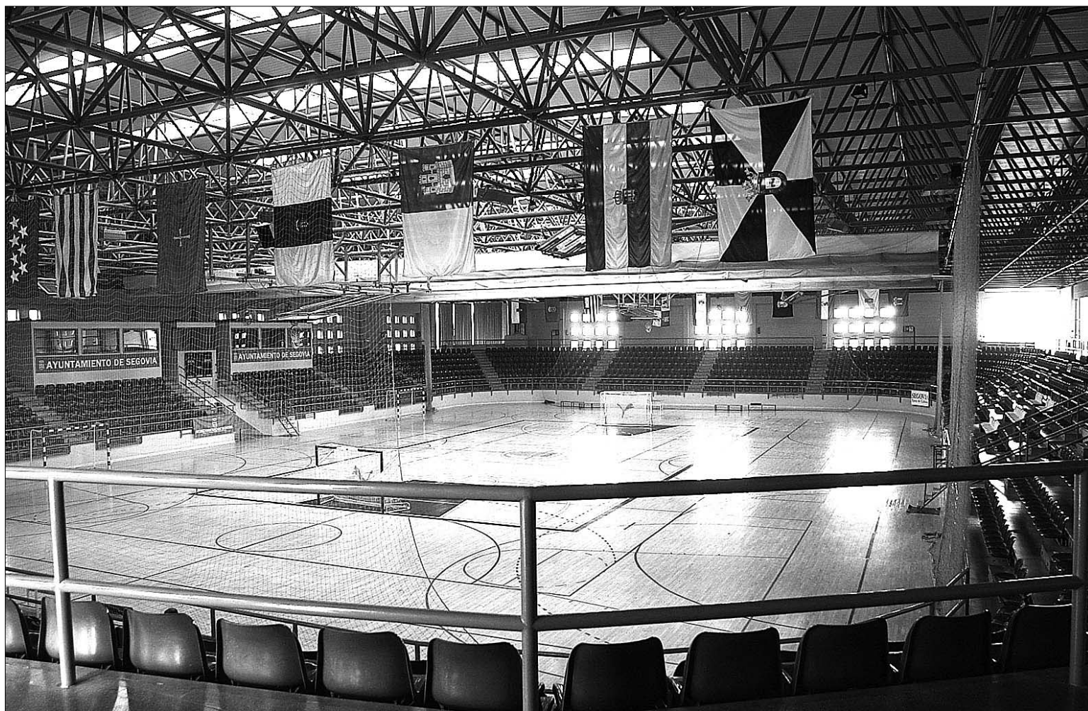
El pabellón Pedro Delgado no verá reformado su interior, ya que se colocará una cubierta exterior para evitar los problemas de goteras. / JUAN MARTÍN
