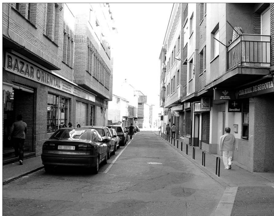
Estado actual de la calle Huertas que se cerrará el lunes al tráfico para el desarrollo de las obras. / GABRIEL GÓMEZ
