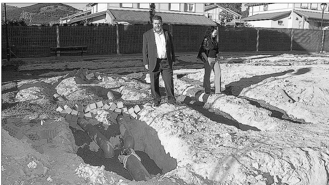
El alcalde David Rubio y la teniente alcalde de La Estación, Paloma Rodríguez, visitando las obras ya comenzadas. / P.L.M.
