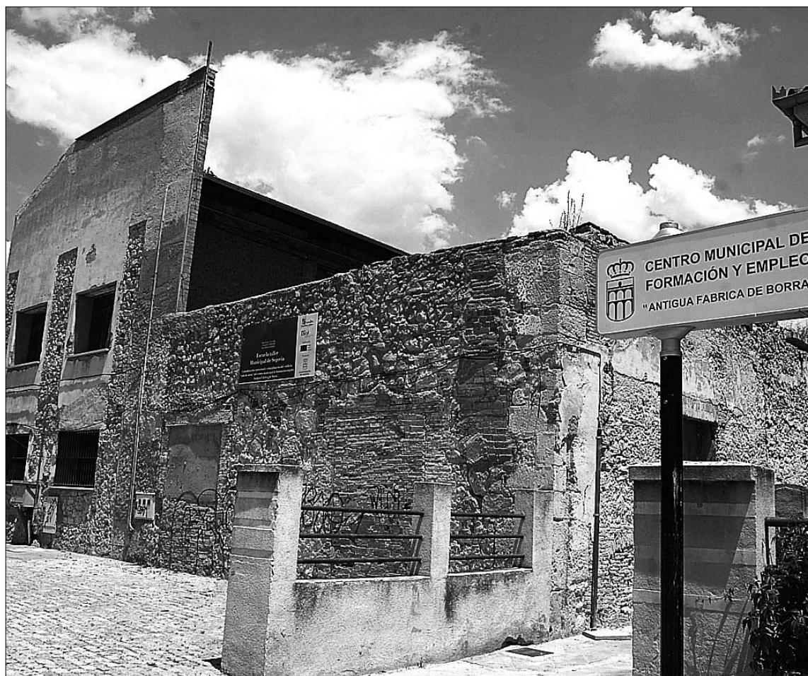
Zona de la Fábrica de Borra que se verá afectada por la rehabilitación, de algo más de 275 metros cuadrados. / JUAN MARTÍN
