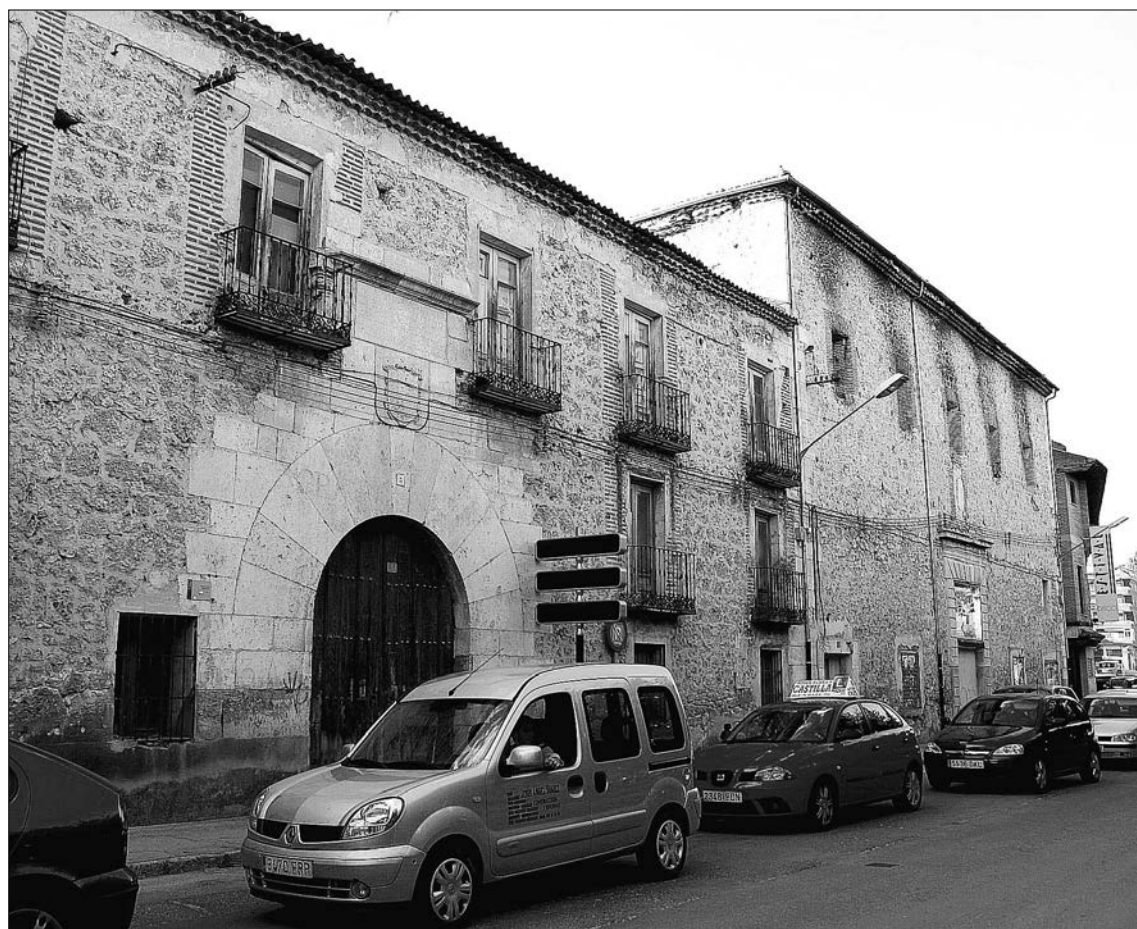
Estado de la fachada del Palacio de Santa Ana, que sufrió un incendio hace varios años y del que aún quedan restos./ G. GÓMEZ
