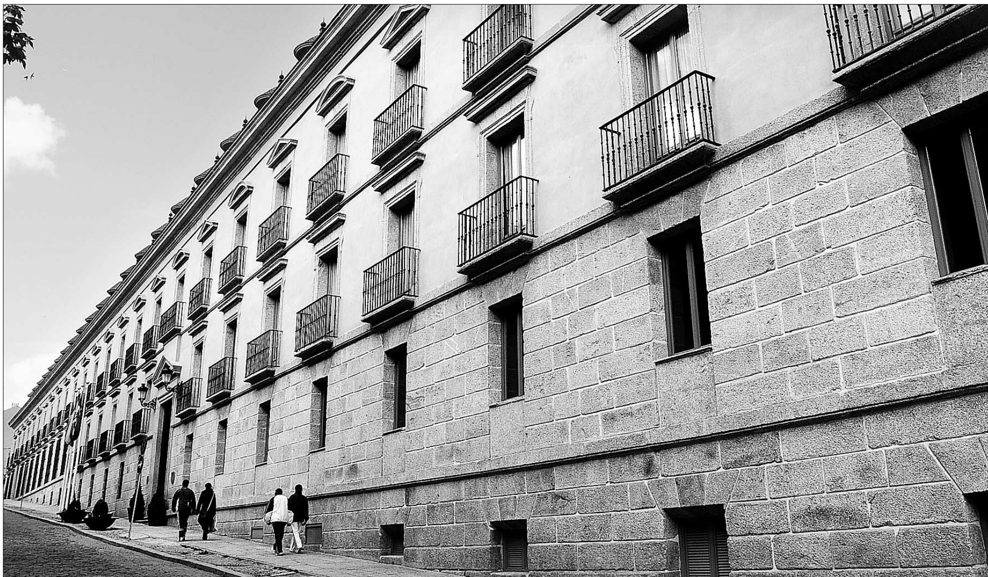
El Parador de La Granja se construyó sobre la antigua Casa de Infantes, construida en el siglo XVIII por Carlos III. Ahora es un establecimiento de cuatro estrellas. /BEATRIZ VELASCO
