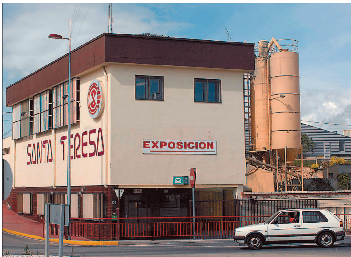
Vista general de las instalaciones que la empresa de material de construcción tiene en La Lastrilla. / JUAN MARTÍN
