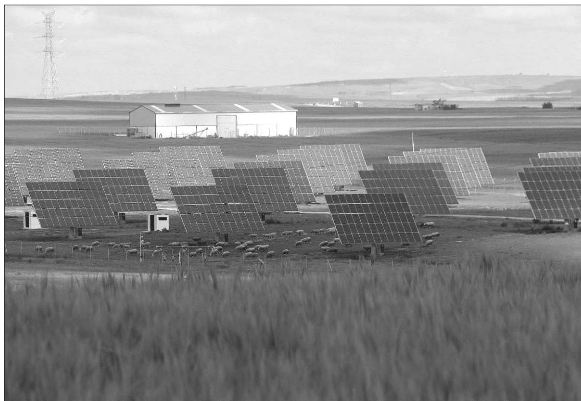
Imagen de parte del huerto solar que ha comenzado a evacuar su energía a la red eléctrica. / F. DESCALZO
