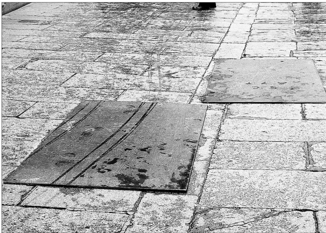
Las actuales losas serán sustituidas por otras de granito de diez centímetros de espesor, sobre solado de hormigón. / F.P.
