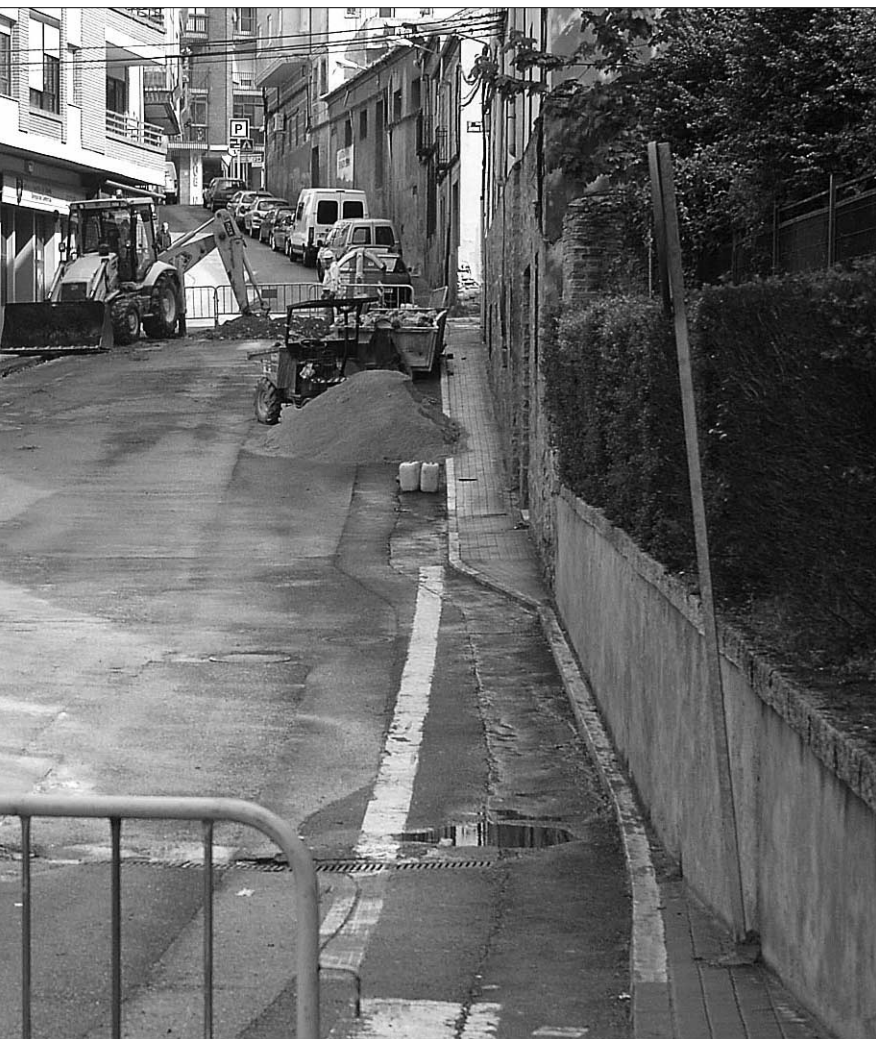
Construcción de un túnel doble (dos sentidos). / JUAN MARTÍN
