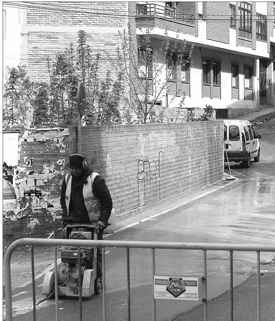
Calle Antonio Machado, ayer por la tarde, en la zona de José Zorrilla, donde está previsto la construcción de un túnel.
