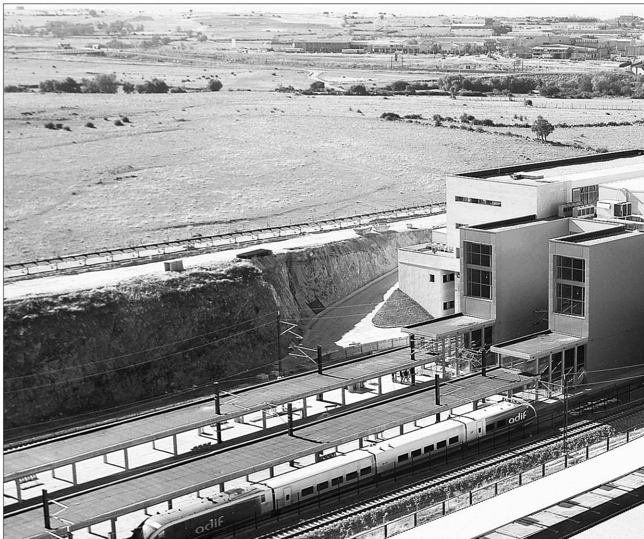
Imagen aérea de la nueva estación del AVE Segovia-Guiomar, que funciona desde el pasado mes de diciembre y sobre la que se habían creado
