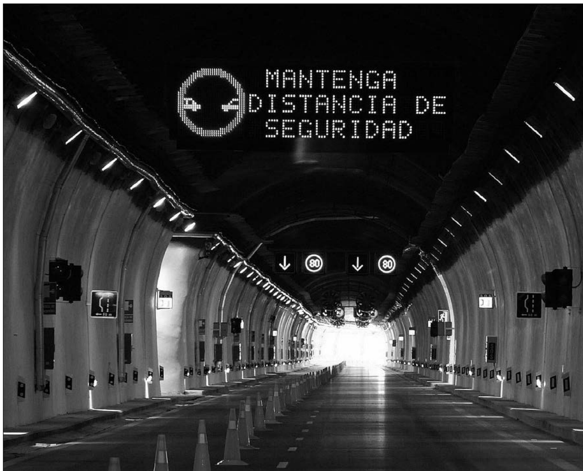
Imagen que presentaba el túnel 1 ayer, inmediatamente antes de ser abierto al tráfico a las cinco de la tarde. / PEDRO L. MERINO
