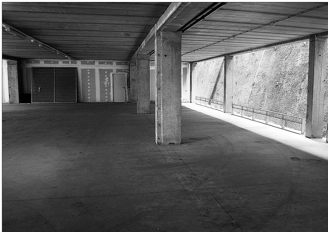
Durante muchos meses los espacios de la planta baja del parking se podían ver sin uso y vacíos. /KAMARERO
