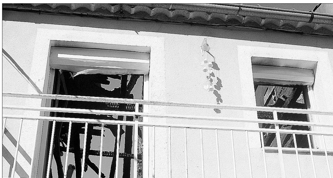
Las cubiertas de los inmuebles quedaron totalmente destruidos por las llamas, que pasaron de una vivienda a otras. / F. P.
