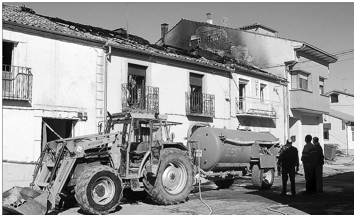
Estado en que quedaron las viviendas, con una cuba de las que se emplearon en las labores de extinción / F. PEÑALOSA
