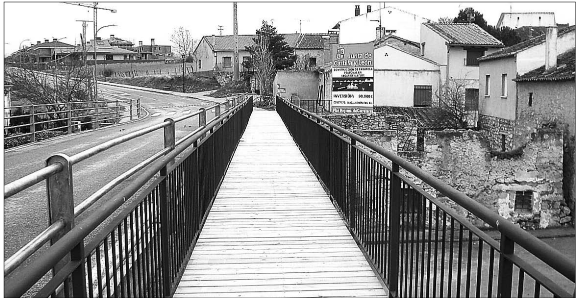
Estado en el que ha quedado el puente tras la actuación de la Junta de Castilla y León. / EL ADELANTADO.
