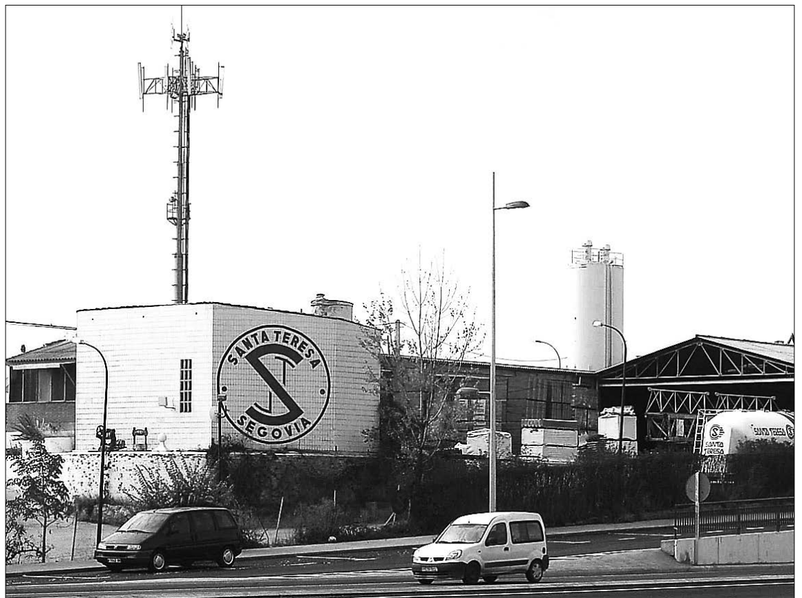
Instalaciones de la empresa de producción y comercialización de materiales de construcción en La Lastrilla. / KAMARERO
