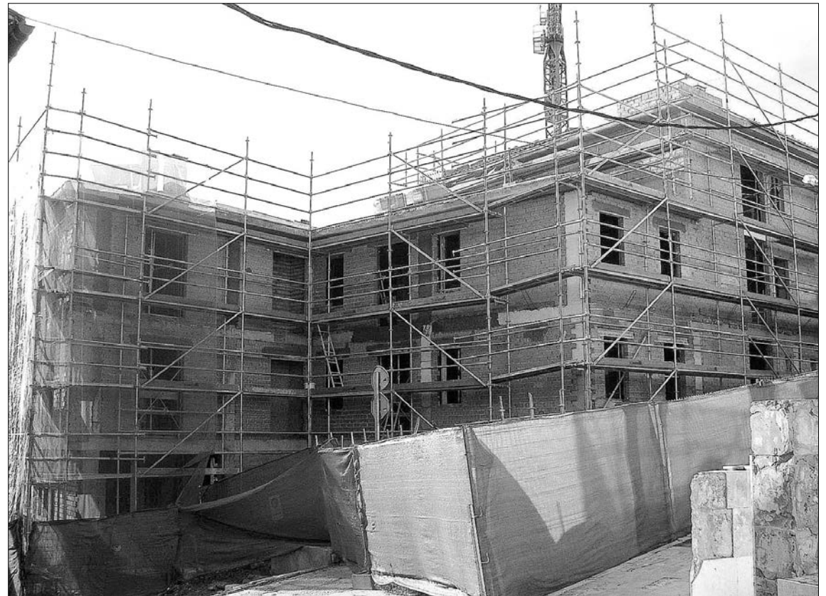
Estado actual de las obras del área de Niñas Huérfanas./GABRIEL GÓMEZ
