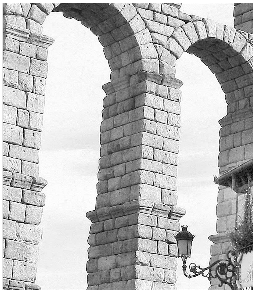
La mayor parte de los establecimientos hosteleros y comerciales segovianos han instalado ya su...
