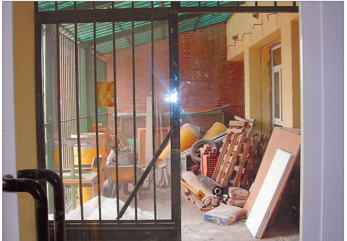
Material de obra apilado en las instalaciones del colegio de Navas de Oro/EL ADELANTADO
