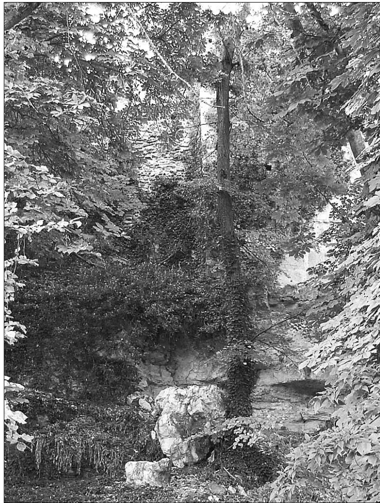
Roca, de al menos un metro de diámetro, que se desprendió de la base del cubo/J.M.
