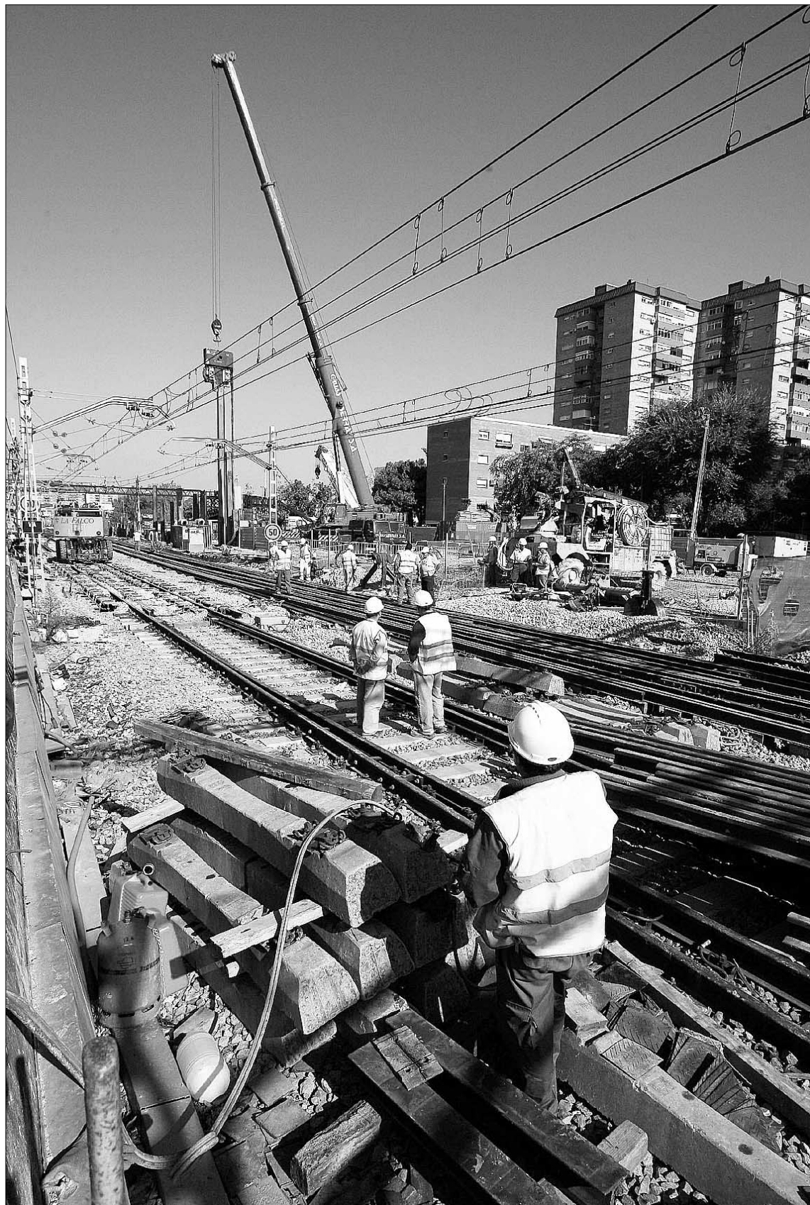
Las obras en el tendido del AVE a su paso por Bellvitge continuaban ayer a buen ritmo. / EFE
