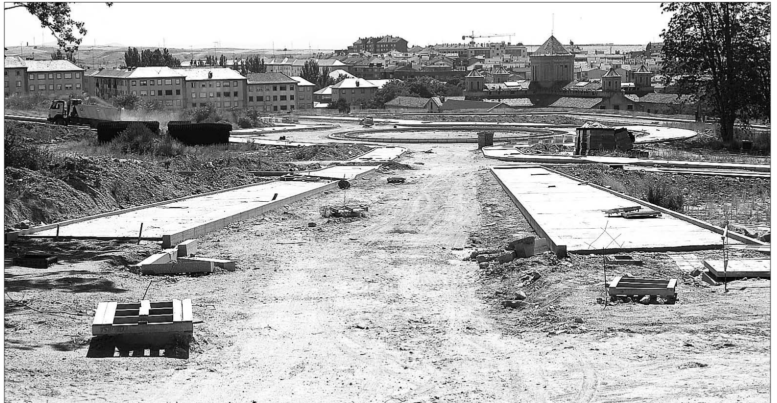
Imagen de los terrenos del Sector I Plaza de Toros, en el que el final de las obras de urbanización coincidirá con el inicio de la construcción de edificios. / JUAN MARTÍN
