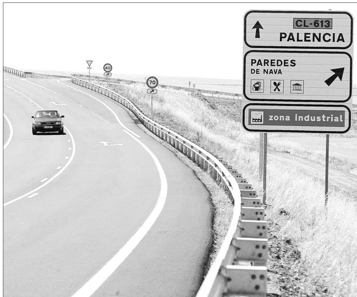
Variante de Paredes de Nava (Palencia), una de las impulsadas por la Junta dentro del todavía vigente plan de carreteras. / IICAL
