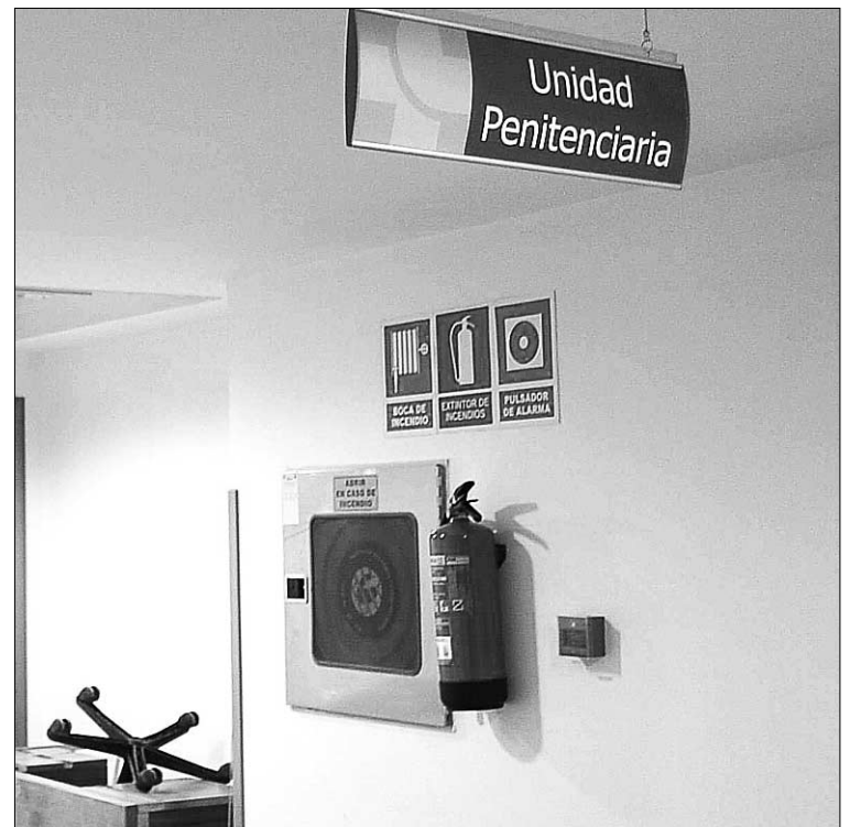
Imagen de archivo del módulo penitenciario, aún en obras./KAMARERO
