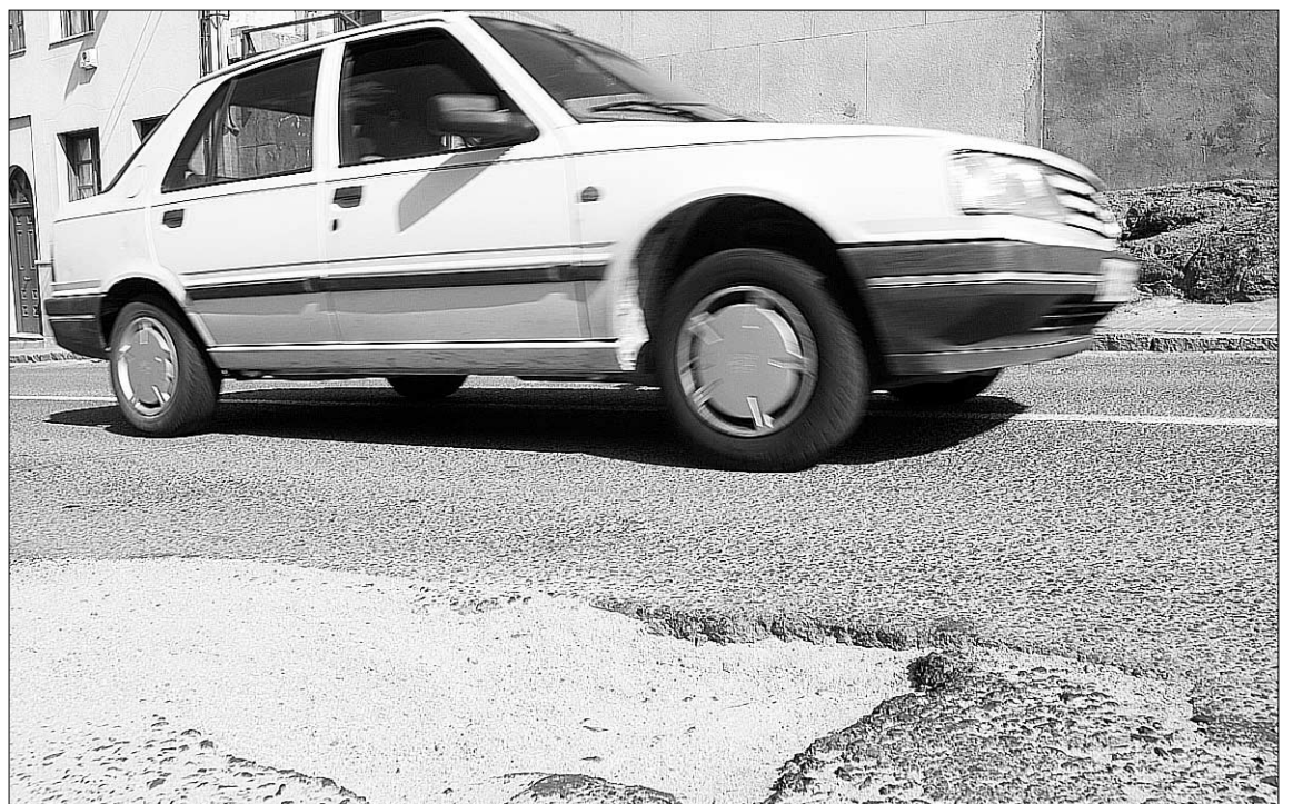
El tráfico rodado en la calle de San Gabriel ha crecido vertiginosamente desde el inicio de las obras de Padre Claret. /KAMARERO
