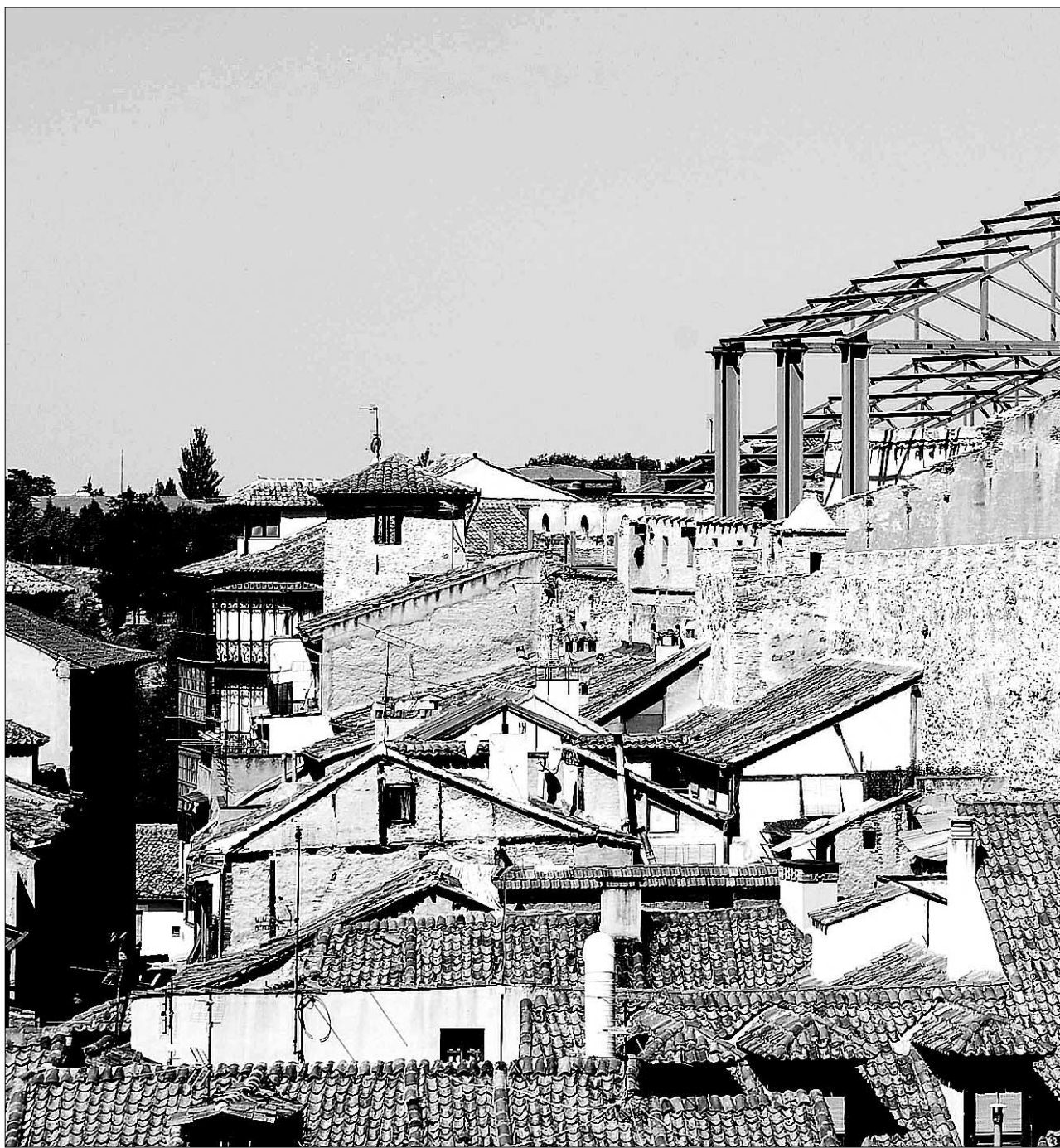
Las obras del Teatro Cervantes fueron paralizadas por la Junta de Castilla y León el 24 de marzo de 2006; durante 16 meses la altura de su
