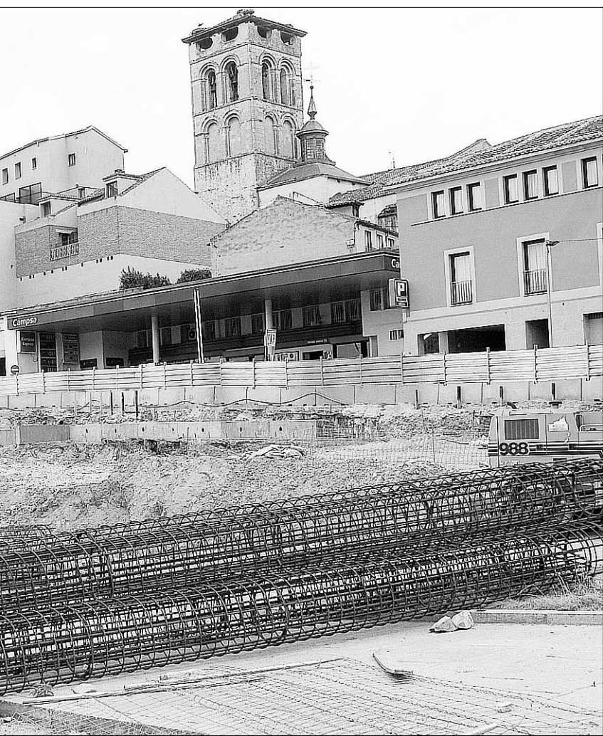
momento en el que comenzarán los trabajos de cimentación y construcción de la estructura./A.K.
