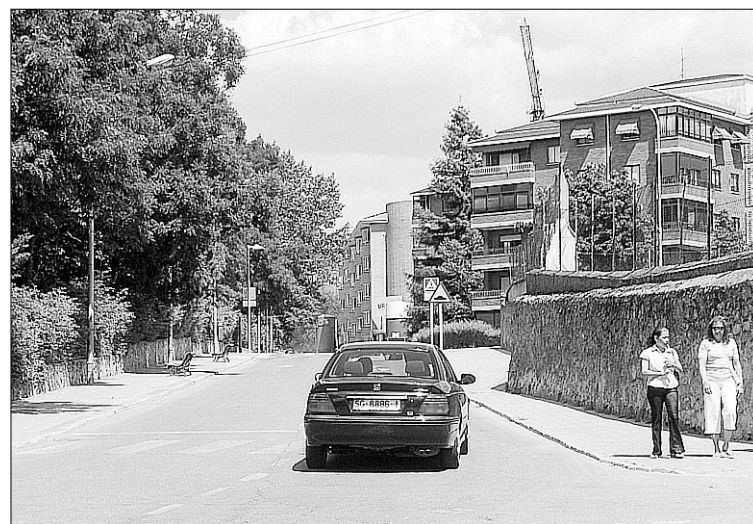
La calle Bomberos quedará desde hoy y durante meses cerrada al tráfico./KAMARERO
