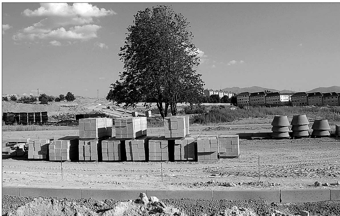
La parcela municipal se encuentra en el denominado Sector 1, donde avanzan las obras de urbanización. / BEATRIZ VELASCO
