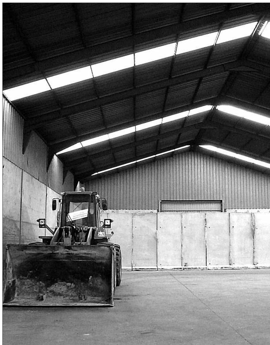
Imagen de una de las naves de pienso, en la que hace unos meses se acumulaban los kilos de p...
