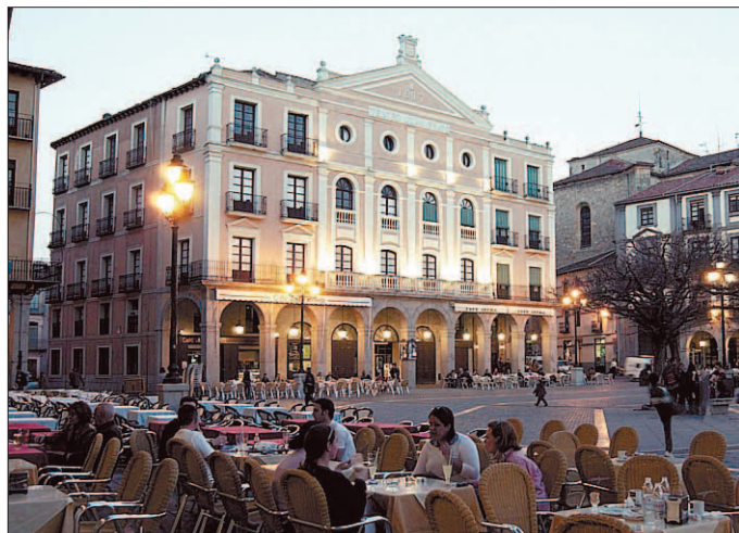
El teatro Juan Bravo permanecerá en obras hasta final de año./ J.MARTÍN
