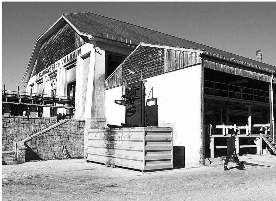
Las instalaciones del Aserradero resultaron muy dañadas en octubre de 2005. // JUAN MARTÍN
