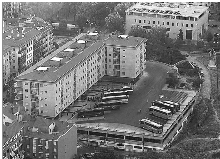
La plataforma insiste en pedir que la estación no varíe su emplazamiento./J.M.
