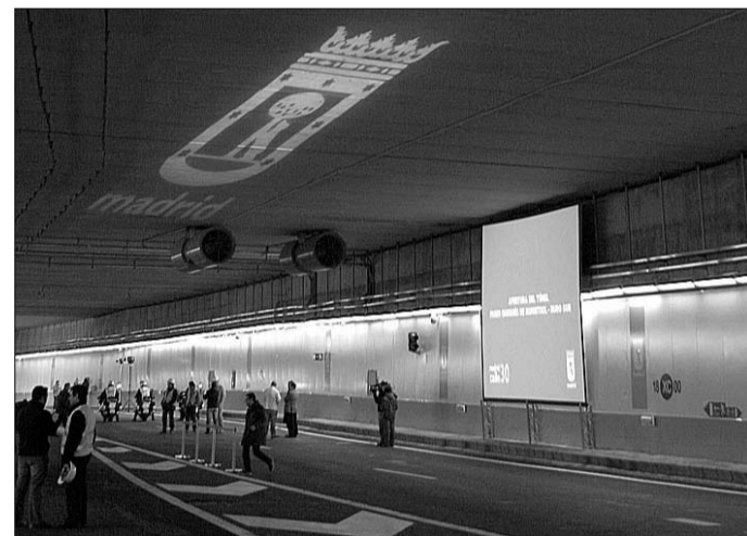
El túnel tiene una longitud de 9.952 metros. / JOSÉ HUESCA (EFE)
