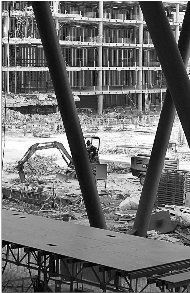
La reconstrucción de la T-4 avanza a buen ritmo. / EFE
