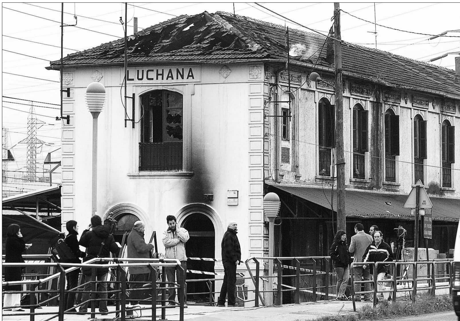
El artefacto explosivo que los proetarras colocaron de madrugada destruyó por completo el edificio de la estación de ferrocarril del barrio de Luchana. / EFE
