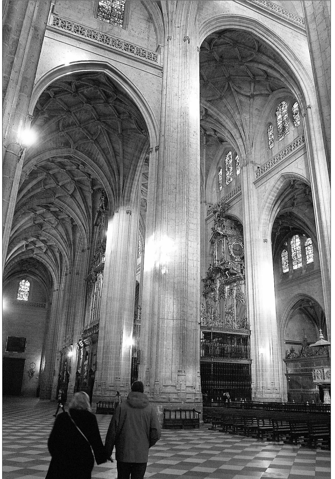
La nave central presenta un alarmante estado de deterioro en algunas de sus zonas.//JUAN MARTÍN
