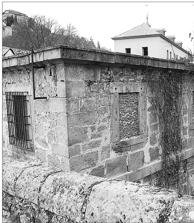
Las obras de la Ceca se adjudicaron por algo más de seis millones. /KAMARERO
