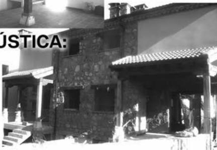
Estructura de madera de 1ª calidad (pino de Valsain) (Pilares forjados, vigas, porches,...)
