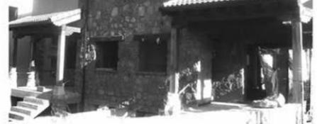
Estructura de madera de 1ª calidad (pino de Valsain) (Pilares forjados, vigas, porches,...)
