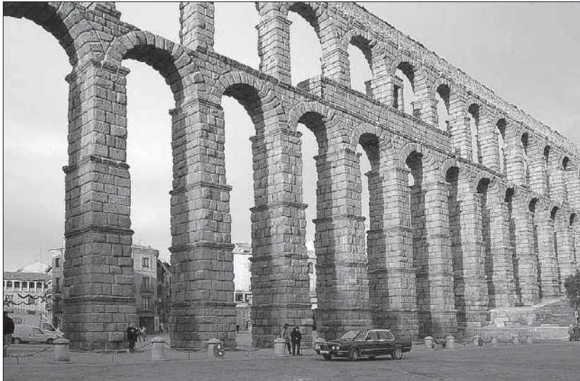
El Acueducto cuenta con 20.400 sillares, distribuidos en 120 pilas y 166 arcos/PEÑALOSA
