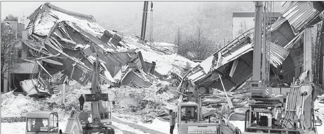
Varios equipos de rescate trabajan entre los escombros un día después de caerse el tejado de las instalaciones de Bad Reichenhall. / ARMIN WEIGEL (EFE)
