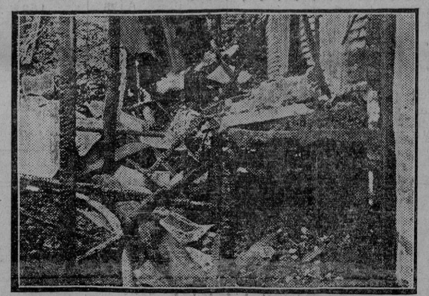
Interior de la carbonería de calle Estoberos, después del incendio de anoche (Foto. S. del Pado.) (Edo. Gori.)
