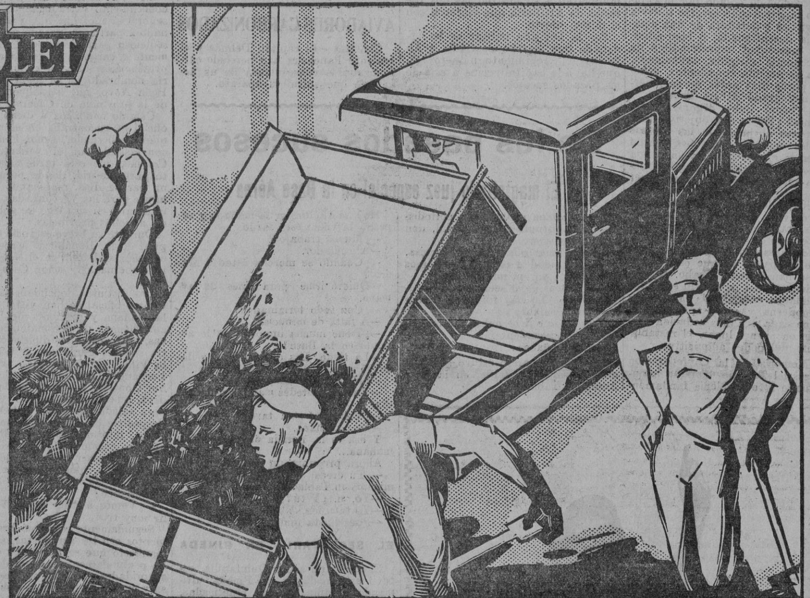
El camión Chevrolet de 3,33 mts. entre ejes, ha sido especialmente adaptado a las necesidades del transporte de materiales de construcción y está equipado con un motor Chevrolet de 53 H. P. efectivos (20 H. P. fiscales).
