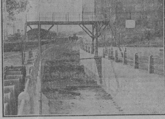
I. Terminado uno de los tramos levadizos del puente de San Telmo, ha comenzado, con el traslado del andamiaje, la instalación del segundo tramo metálico. II.—En las inmediaciones de la Torre del Oro ha sido instalada una pasadereza para peatones sobre la trinchera destinada al tren de mensajerías.
