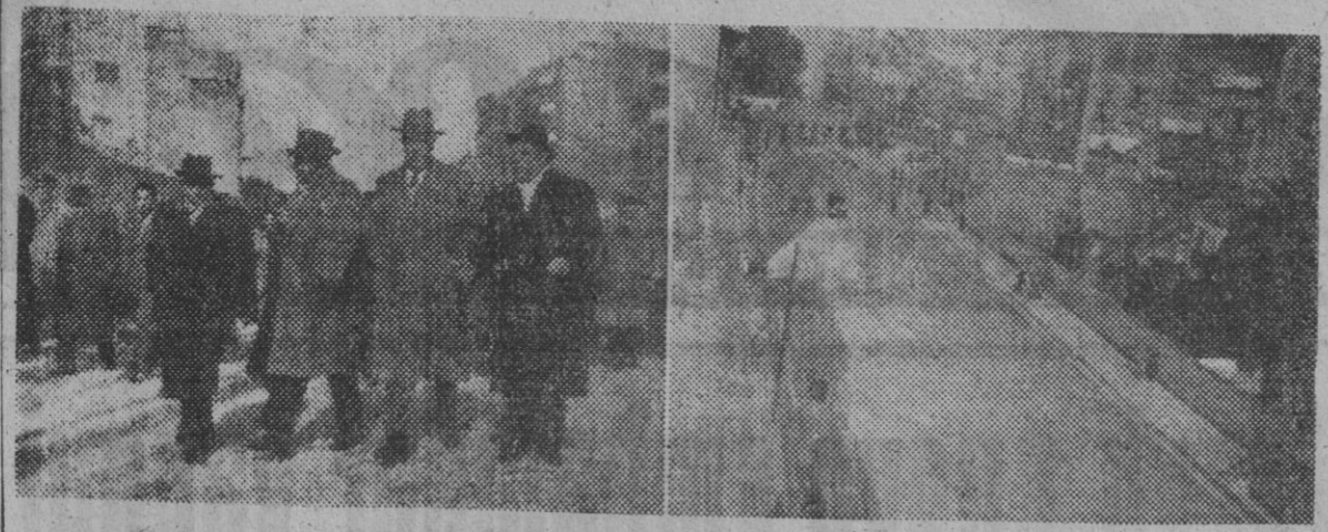
1. Con asistencia del gobernador civil, teniente de alcalde de urbanización y otras autoridades, se ha procedido a la apertura del tráfico en la calle Príncipe de Asturias. — 2. Aspecto de la vía después de las obras efectuadas. (Fotos P. de Rozas)
