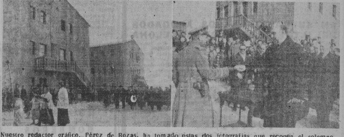
Nuestro redactor gráfico, Pérez de Rozas, ha tomado estas dos fotografías que recogen el solemne momento de la bendición de un grupo de viviendas, construido en terrenos cedidos por el Ayuntamiento de Barcelona, y cedidas en donativo, por el Excmo. señor gobernador civil, a la Plantilla de la Policía Armada, detalle que puede apreciarse en la foto de la derecha, donde el señor Acedo Colunga hace entrega del título posesorio a un guardia.
