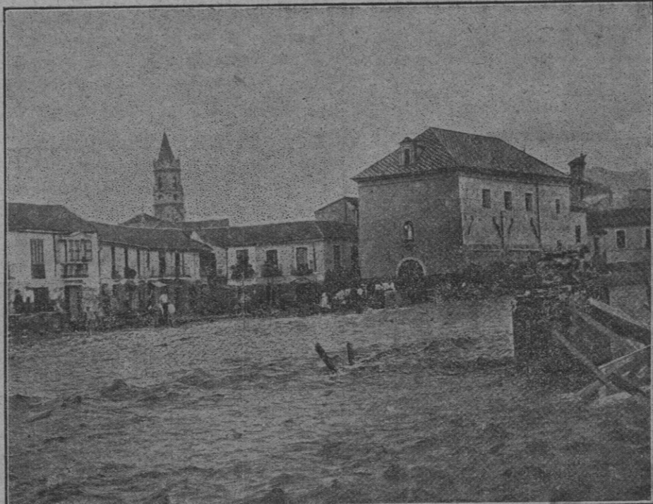
Málaga.—Restos del Puente de la Aurora destruido por la corriente del Guadalmedina
