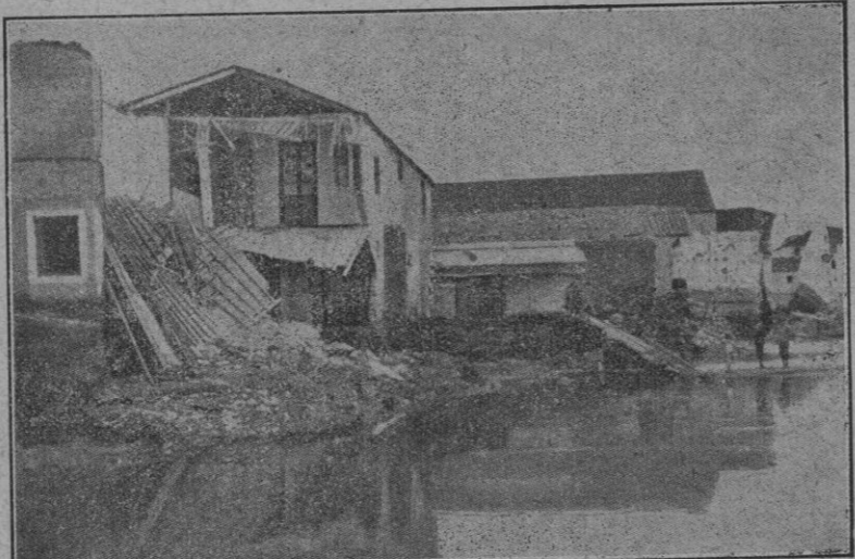
Málaga.—Casas de Pescadores destruidas por la corriente
