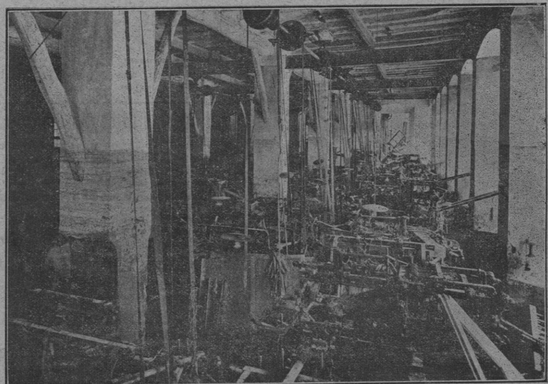
Manresa.—Sala de máquinas de la Fábrica de Faura é hijos
