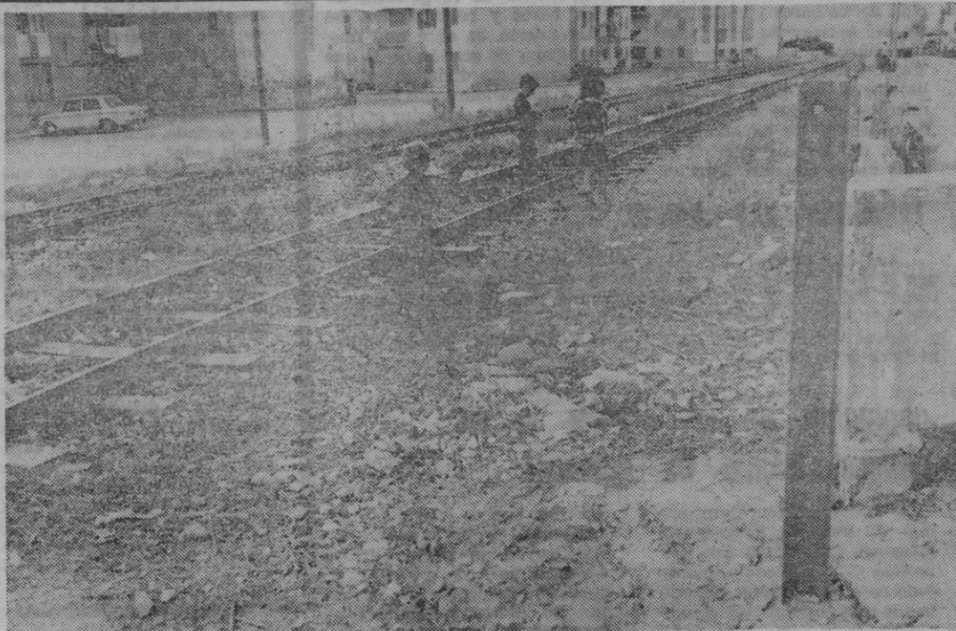
Si bien el Ayuntamiento comenzó ayer a colocar postes metálicos para la reparación de la pared que separa las vías de la barriada, FEVE continúa sin hacer nada para restablecer el servicio.
