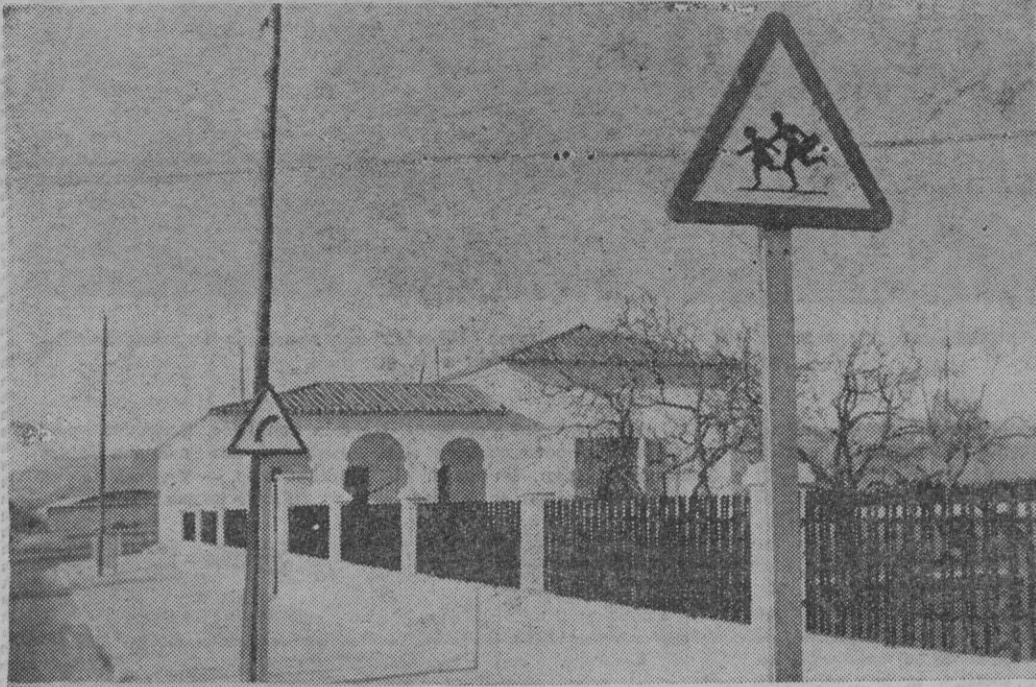
Fachada, aceras y vallas junto a la carretera que han sido puestas recientemente por el Ayuntamiento de Marratxi.
