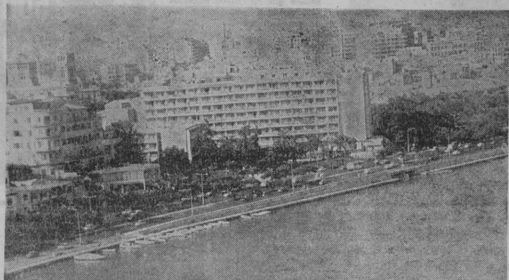
Ante el temor de una especulación del suelo en los solares resultantes de diversas demoliciones de edificios, el Ayuntamiento ha decidido suspender por el plazo de seis meses la concesión de licencias de obras.
