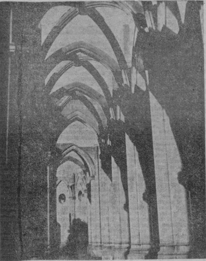
FRAGMENTO DE LA BASILICA TERESIANA EN CONSTRUCCION, EN ALBA DE TORMES.
