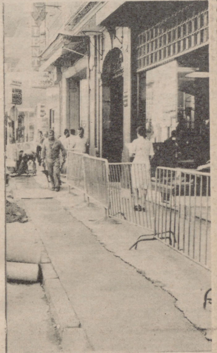
Desde luego, el ciudadano no encuentra respiro en la calle. Las obras se multiplican por todas partes y a veces tiene que hacer verdaderos equilibrios para sortear vallas, calderetas, cables, etc. Valladolid es una ciudad en obras permanentemente. En la foto, un aspecto de la calle Santiago. Es sólo un ejemplo.
