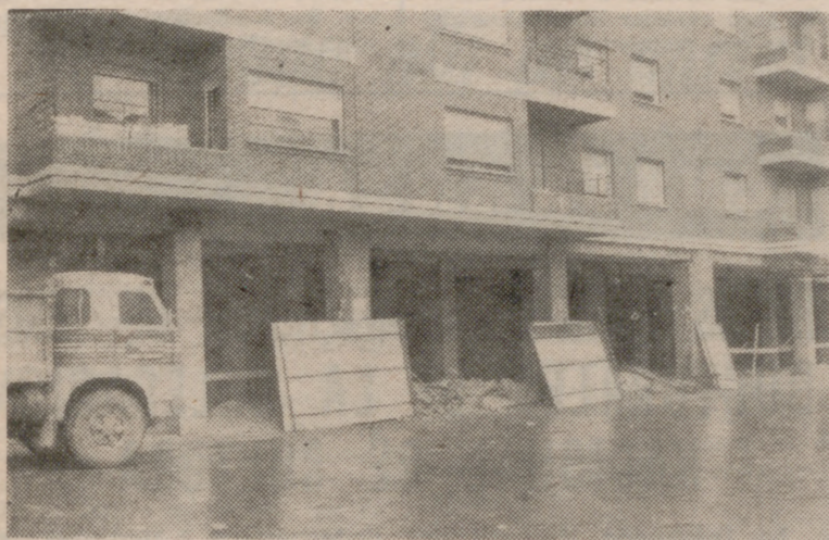
En estos locales de la calle de Nuestra Señora se inician las obras para el nuevo ambulatorio.
