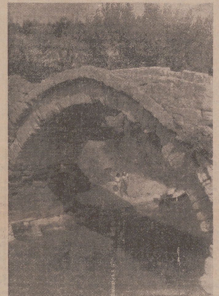
Una panorámica del puente romano de Cihuri.
