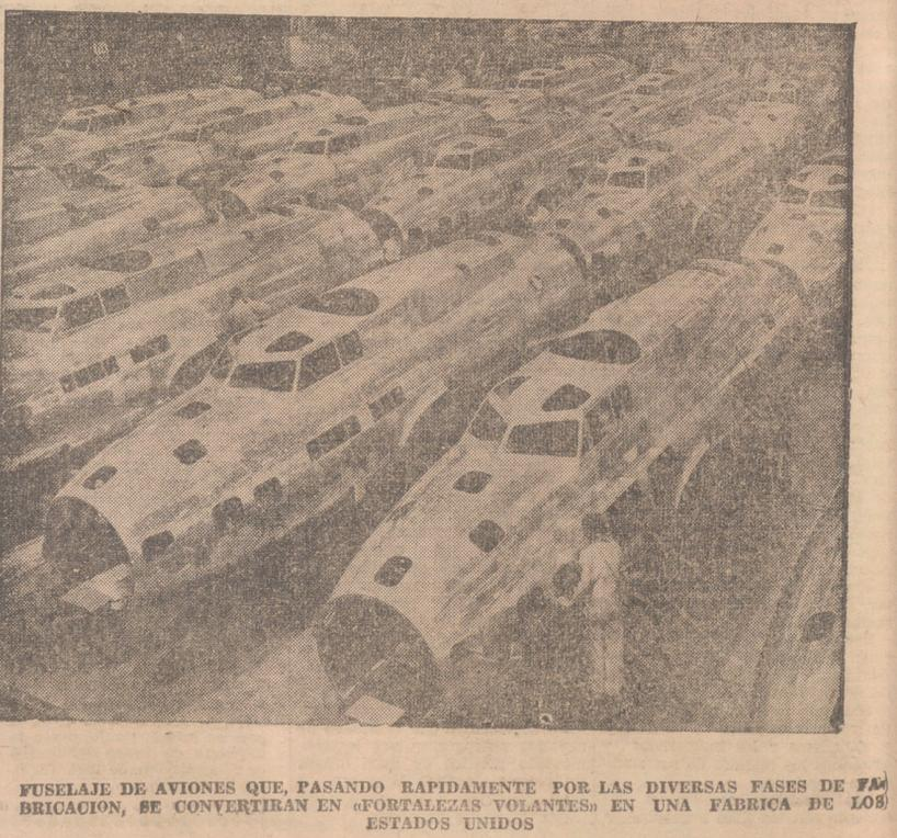
FUSELAJE DE AVIONES QUE, PASANDO RAPIDAMENTE POR LAS DIVERSAS FASES DE FABRICACION, SE CONVERTIRAN EN «PORTALAZAS VOLANTES» EN UNA FABRICA DE LOS ESTADOS UNIDOS
