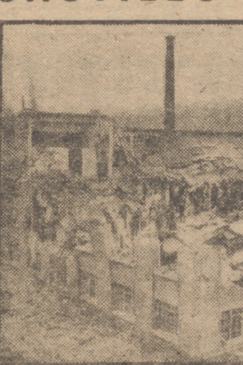
En una fábrica de tejidos de Pfullingen (Alemania sudoccidental) se hundieron los dos pisos superiores, arrastrando entre los escombros a muchos obreros. El suceso ocurrió el 12 del actual. Tres cadáveres aparecieron entre los escombros; se teme que haya alguno más. Los testigos de la catástrofe dicen que la fábrica se hundió como un castillo de naipes. En la foto, la Policía y los bomberos proceden a la busca de los cuerpos sepultados.
