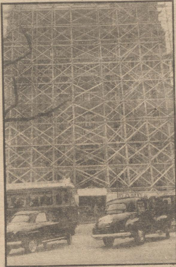
—Y de herraje para sujetar los pies derechos y tramos? —Se ha empleado una tonelada. —¿Cómo será la obra a realizar? —Se desmontarán todos los salientes y se hará una nueva fachada.
