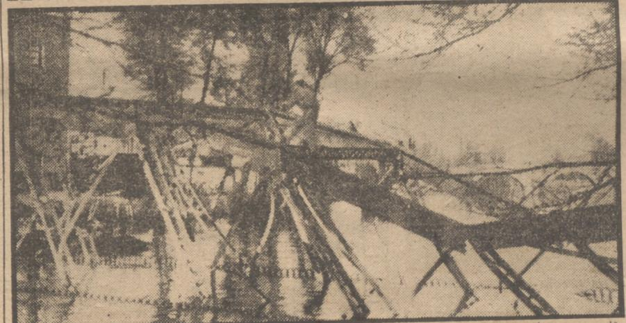
Vista del puente sobre el río Cabe, en Monforte de Lemos, que se hundió al saltarse uno de sus pilares. Sobre el arco del puente se ve a un obrero y al fondo se aprecia la estructura del viejo puente romano, por el que ahora se efectúa el tráfico. (Foto Cítrica.)
