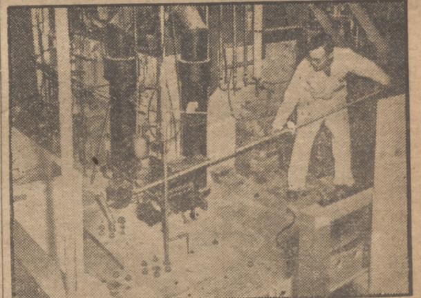
Paul Schaffert trabaja rápidamente, con esta cubeta de largo mango, e introduce el mineral activo a través de unos orificios hechos en el techo de la cámara de hormigón. (Foto A.)
